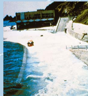
日本秋田男鹿水族館。1983年5月26日日本海海嘯侵襲期間，水族館停車場內的車輛被水淹沒。(日本土木研究所·宇多高明)
